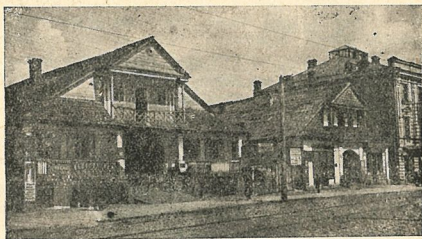
Два „заїзди“ старовинної будови при вул. Леніна біля № 56.
